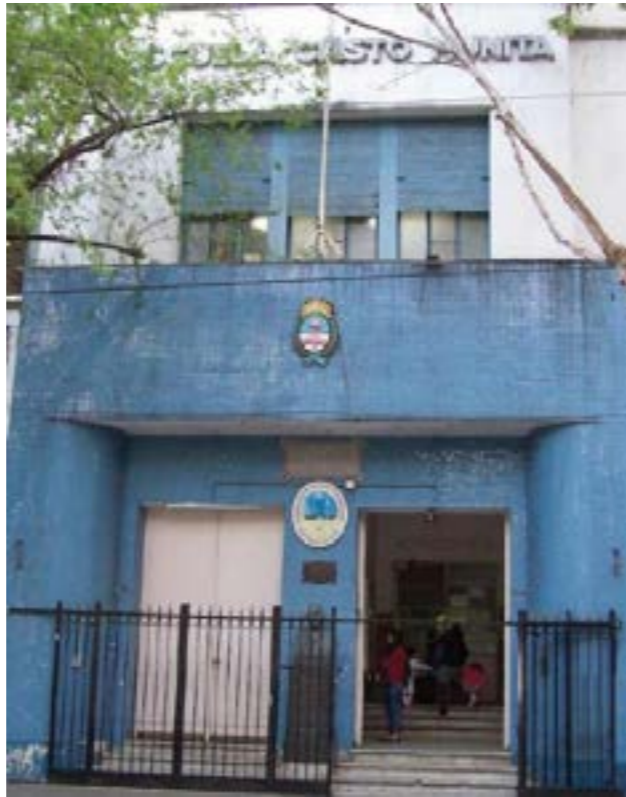
Fachada de la escuela N°1 D.E. 10 "Casto Munita"
