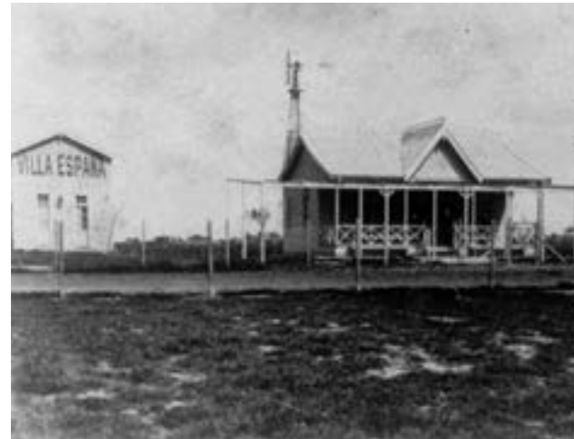
Estación de Tren (Villa España). Antes.
