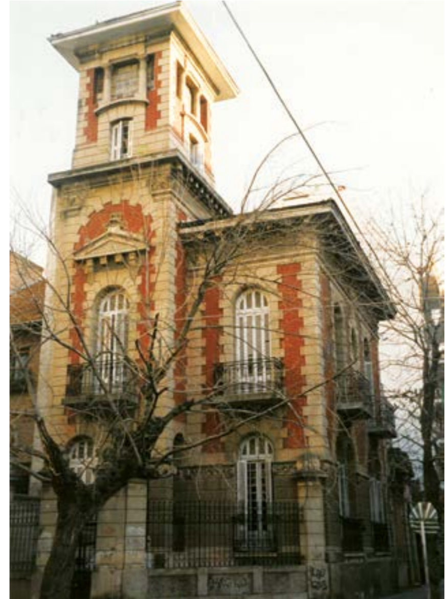
Fachada de la casona.
